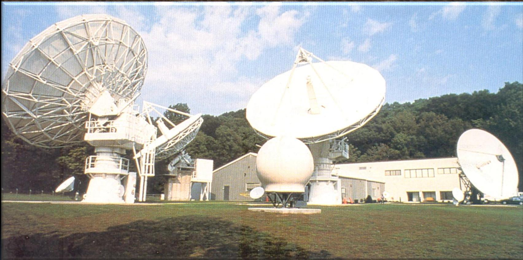
Сложный инженерно-технический комплекс, в состав которого входят мощные параболические антенны диаметром более 10 м с высоким коэффициентом усиления и надежные средства наземных и спутниковых линий связи. Каждая LES имеет трехцифровой номер.
